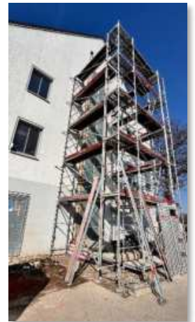
Der Aufzug wird gebaut.
