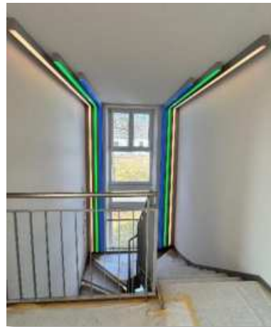
Treppenaufgang in den 1. Stock
