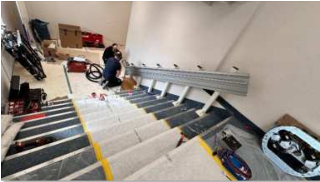
Lift im neuen Durchgang zum Neubau
